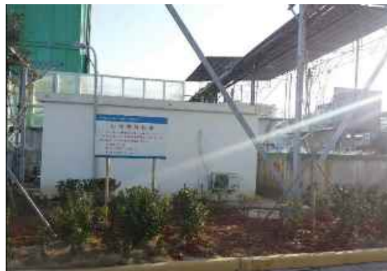
污水处理设施
